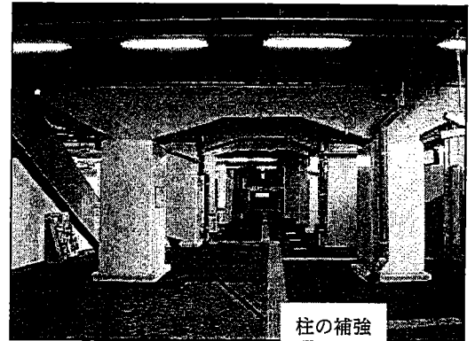
駅舎の耐震対策（柱の補強） 【鉄道事業者に対する補助】 （過年度実施例：近鉄今里駅）
