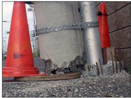
現在の「関空連絡橋」は左上写真のように途中で途切れ、暴風で倒れた「電柱」は右上写真のように今も仮復旧のままです。
