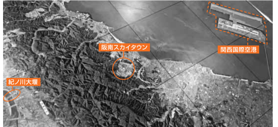
紀ノ川大堰位置図 紀ノ川大堰の隣にある「水ときらめき紀ノ川館」床面航空写真
